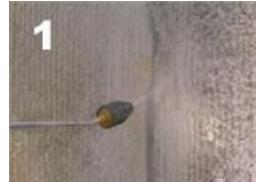
По всей длине трещин, швов, стыков, сопряжений, примыканий и вокруг ввода коммуникаций выполнить штрабы П-образной конфигурации сечением не менее 25x25 мм. Штрабы очистить щеткой с металлическим ворсом. Удалить рыхлый слой бетона (при наличии такового).
